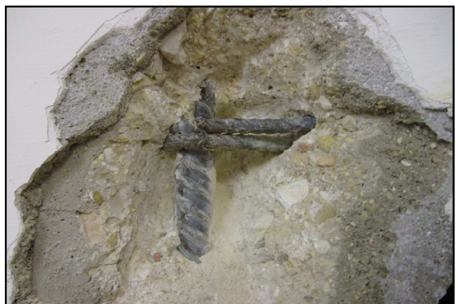
Dettaglio della scarificazione eseguita.
