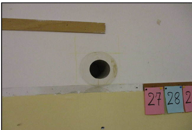
Particolar del carotaggio eseguito.
