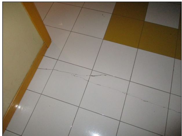
Foto n°2 -3 – Vista d'insieme e di dettaglio delle fessure formatesi in corrispondenza del giunto termico tra US1 e US2
