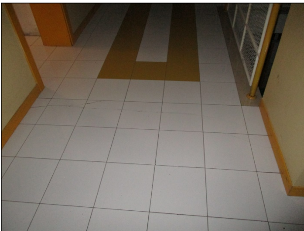
Foto n°2 -3 – Vista d'insieme e di dettaglio delle fessure formatesi in corrispondenza del giunto termico tra US1 e US2
