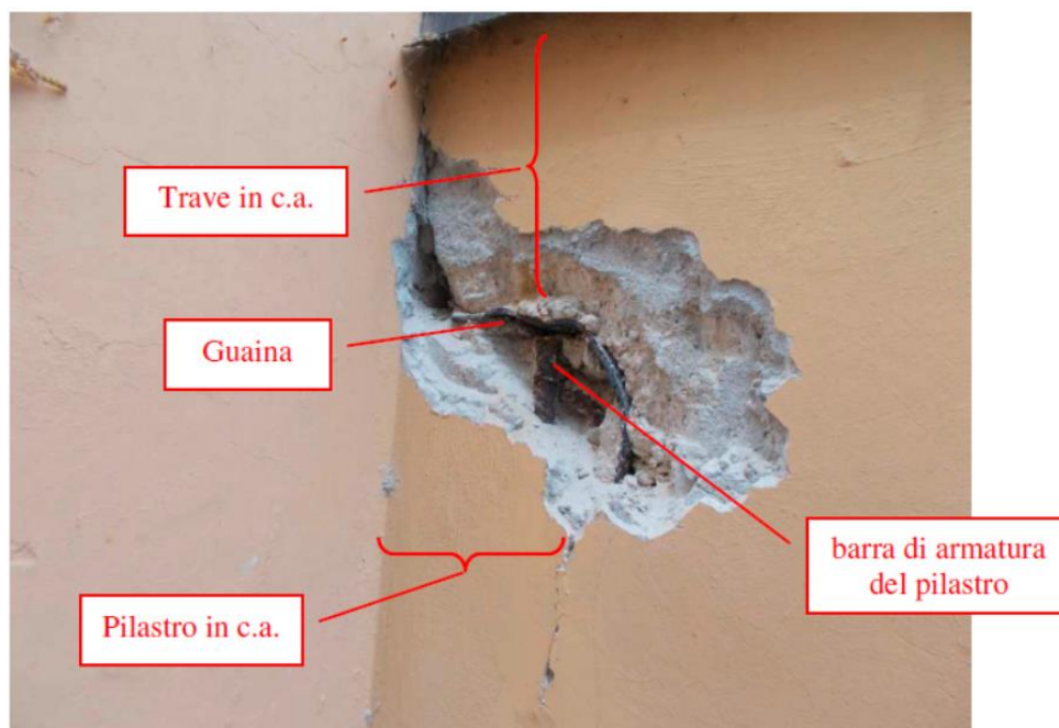
Figura 11 – Foto particolari strutturali sella
