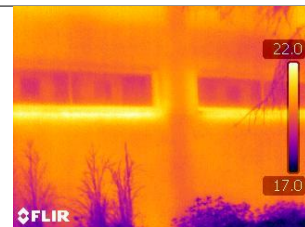
Figura 22 – Visione pilastri e travi perimetrali
