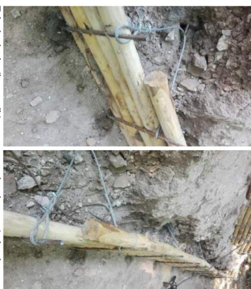
Tale tipologia di consolidamento consiste in una derivazione della tecnica delle palizzate in legno; infatti in sostituzione dei montanti, in assenza di castagno, conficcati a terra, vengono apposte barre in acciaio ad aderenza migliorata, qui della sezione di D. 25 mm e della lunghezza di 4 ml; queste, ogni due, vengono poi tirantate a terra con cavi di acciaio, ad esse agganciati, cementati in profondità su alloggiamento perforato e pulito con botaccia.
